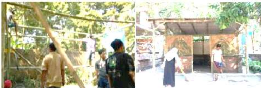
r 2. Pembangunan fisik taman baca Tunas Merapi
