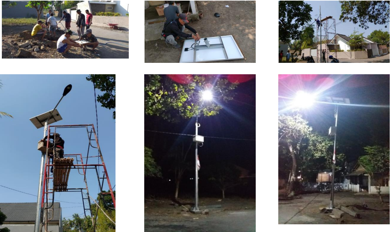
Gambar 3. Dokumentasi pemasangan PJU PLTS
