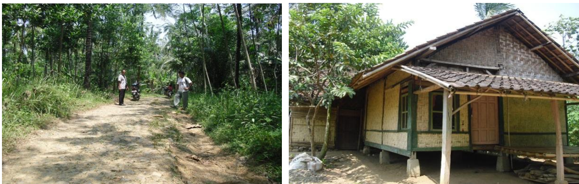
Gambar 5. Kondisi Rumah Warga Desa Cilangkap
