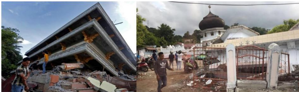
Gambar 1. Kondisi Pidie Jaya pasca terjadi gempa bumi dengan magnitudo 6.5 S.R.
